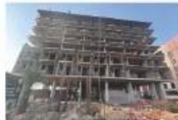
निर्माण कार्य प्रगति पर
